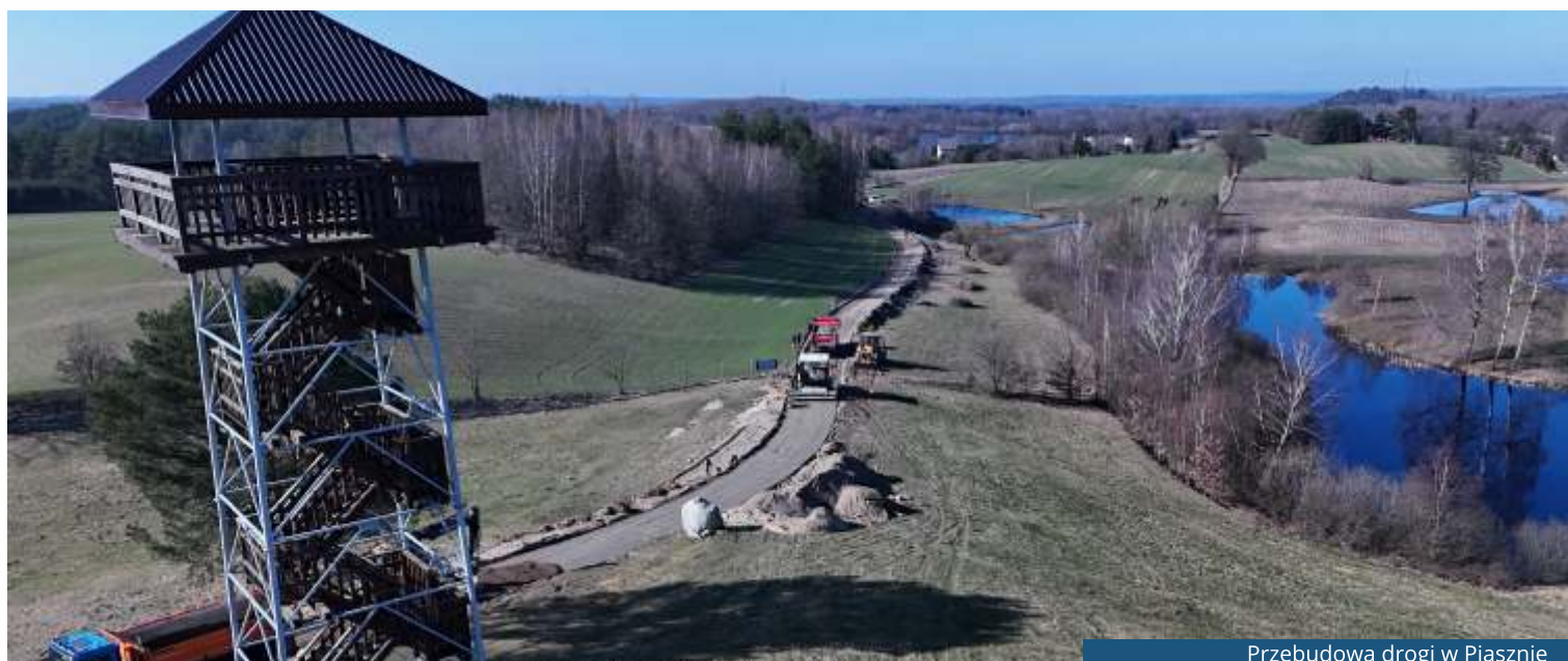
Przebudowa drogi w Piasznie
